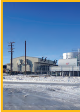
AVEC Stebbins Plant
